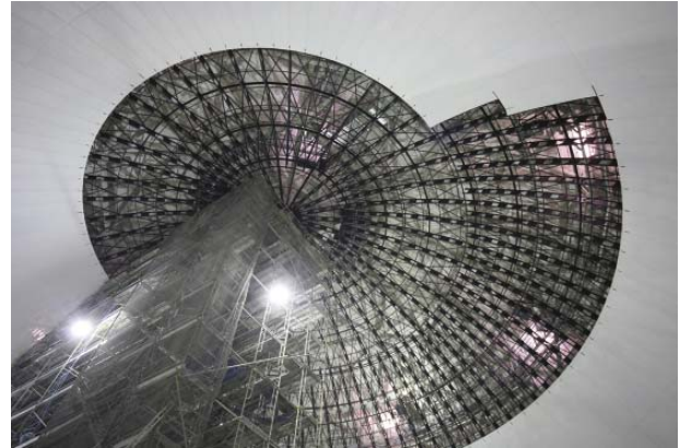
写真2 施工中のドーム
