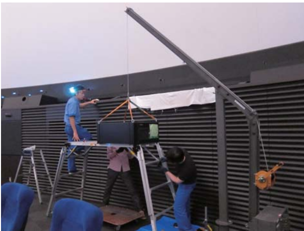
クレーンを使った全天デジタルプロジェクター交換作業
