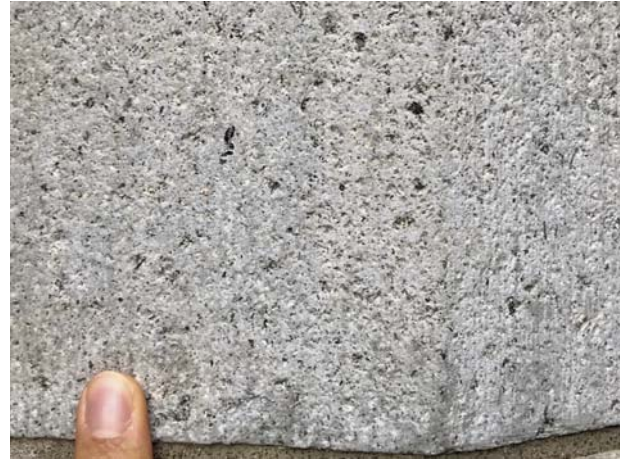
写真5：渋沢史料館青淵文庫外壁の「月出石」
