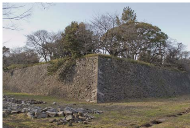
写真2 二之丸南東部石垣
