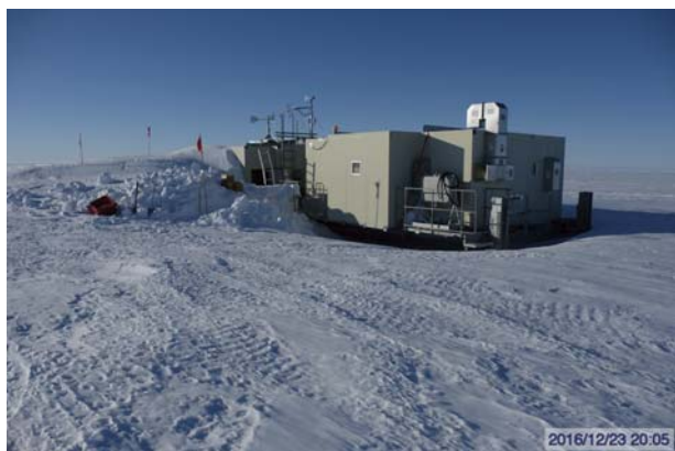
写真7 S-17 拠点小屋
