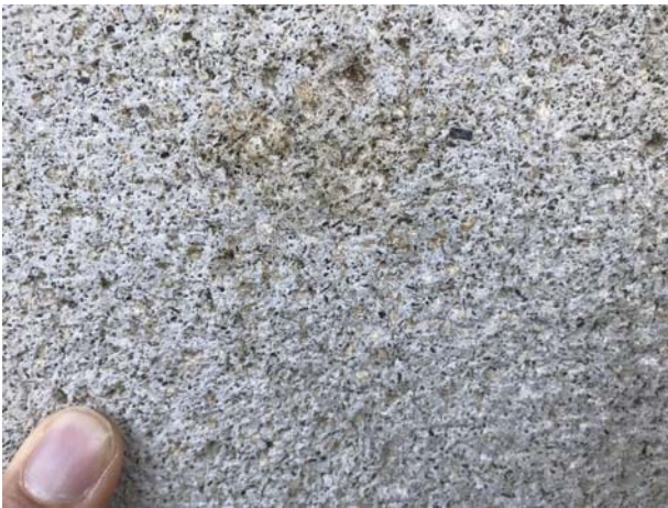
写真4：名古屋市役所本庁舎外壁の石材（ビシャン仕上げ部分）
