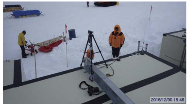
写真2 拠点小屋屋上に三脚を設置し撮影
