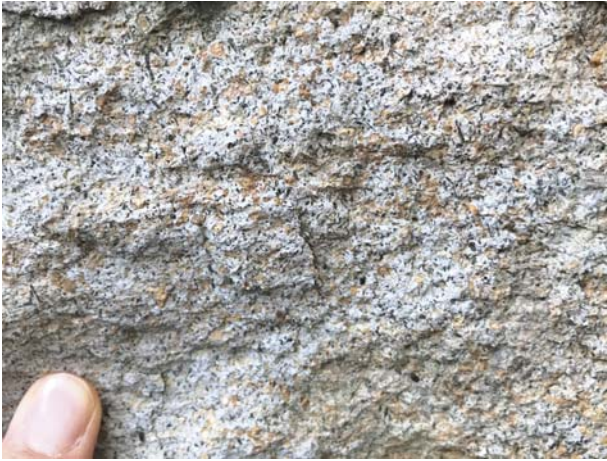
写真3：名古屋市役所本庁舎外壁の石材（割肌仕上げ部分）
