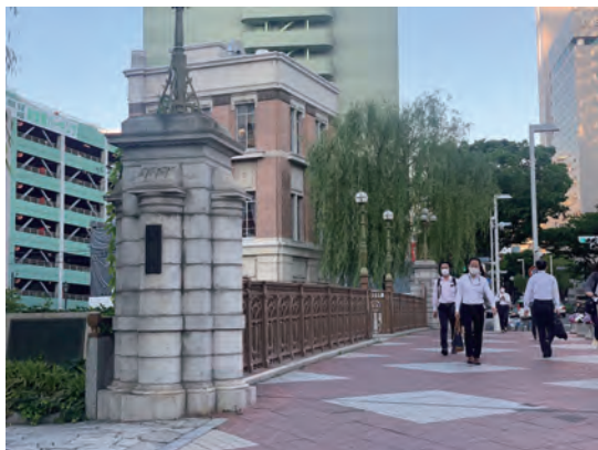
写真2：1987（昭和62）年に改修した納屋橋
